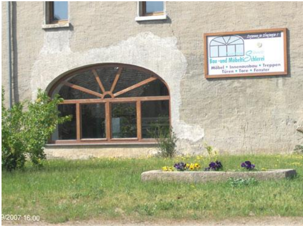
Bau- und Möbeltischlerei Schmole – Smolic blidarnja ein Stallgebäude wurde ausgebaut – pretvarjena hródz
