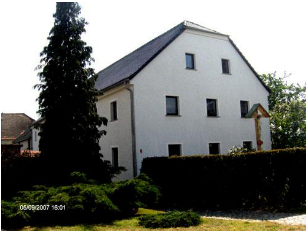
Massives Wohnhaus mit Krüppelwalmdach, Hecke als Zaun
