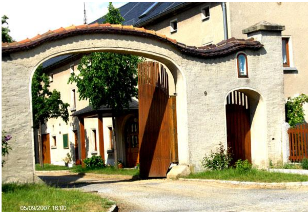
Das Wohnhaus mit Torbogen, Hoftor, Lindenbäume domske z wrotami a lipomaj na dworje
